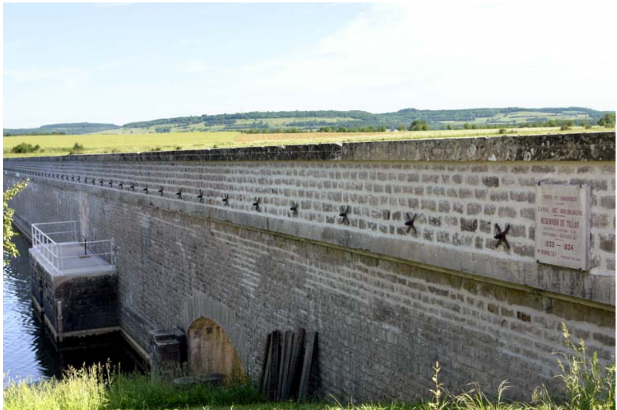
Le barrage, face réservoir.
