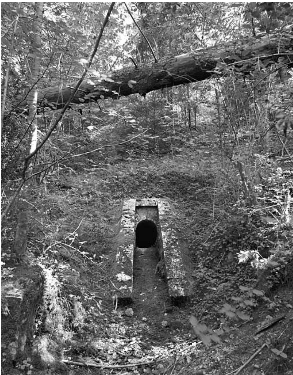
Vue d'ensemble de la tête aval (ouest).
