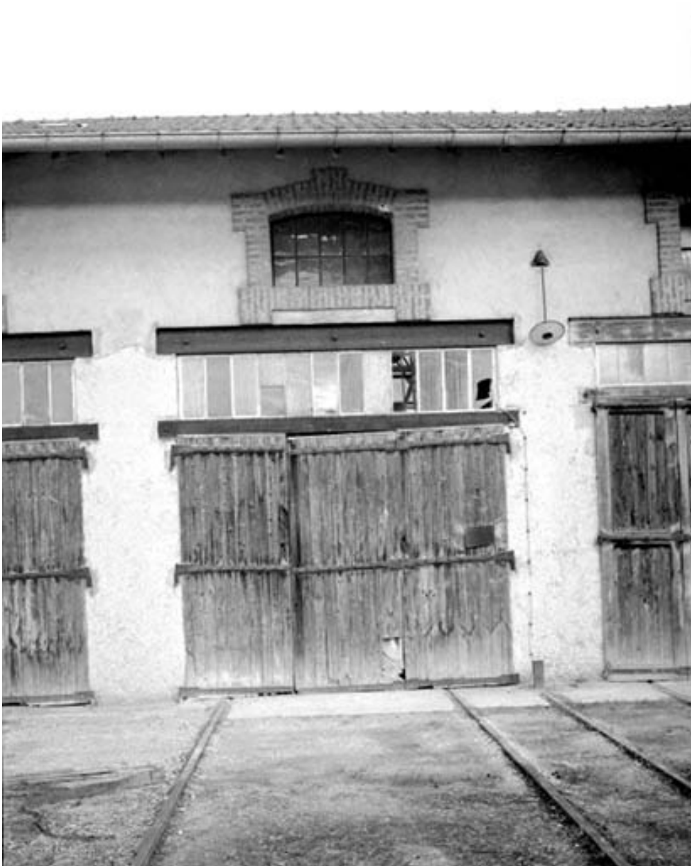
Détail d'une travée de la scierie.
