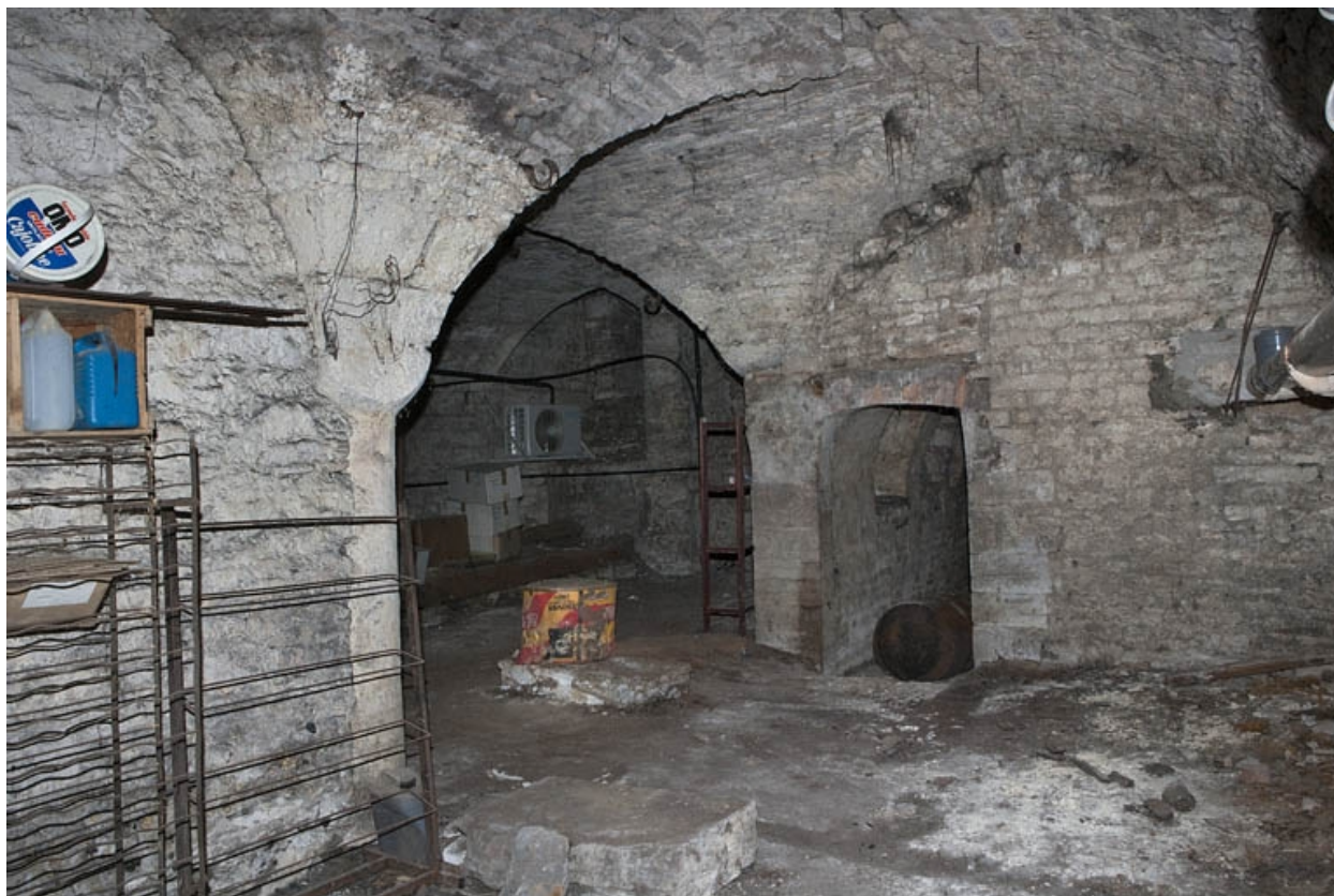
Logis principal, sous-sol : cave A, vue d'ensemble.
