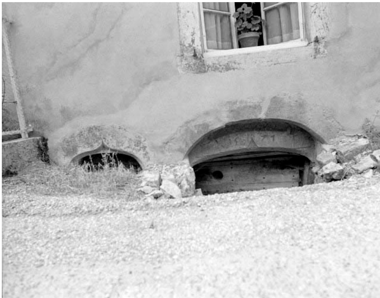
Façade est : entrée de cave, en 1976.
