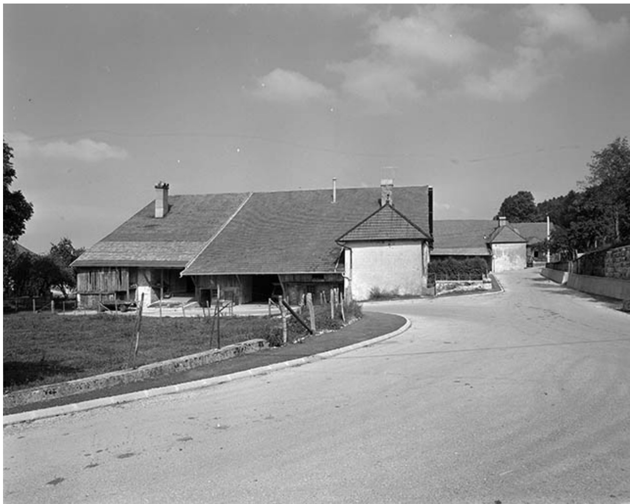
Vue d'ensemble des fermes.
