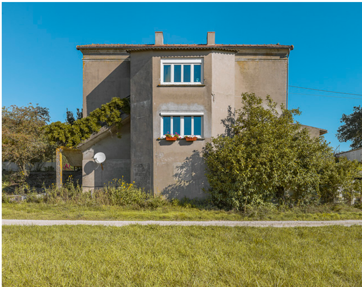
Façade arrière avec l'ajout d'un avant-corps central.
