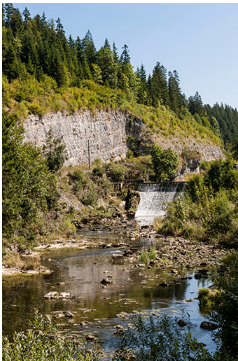
Le barrage dans les gorges de Fourpéret.
