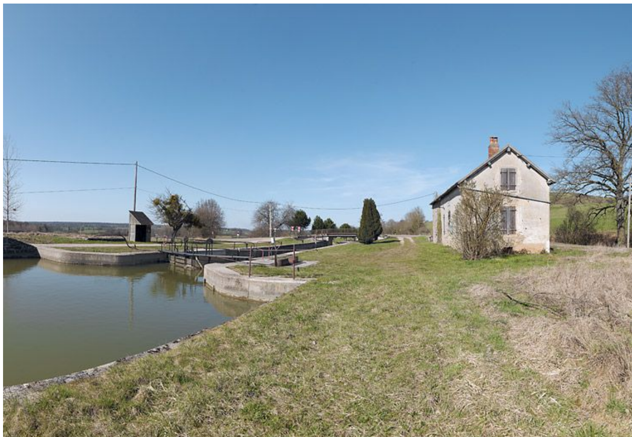
Le site d'écluse vu d'amont.
