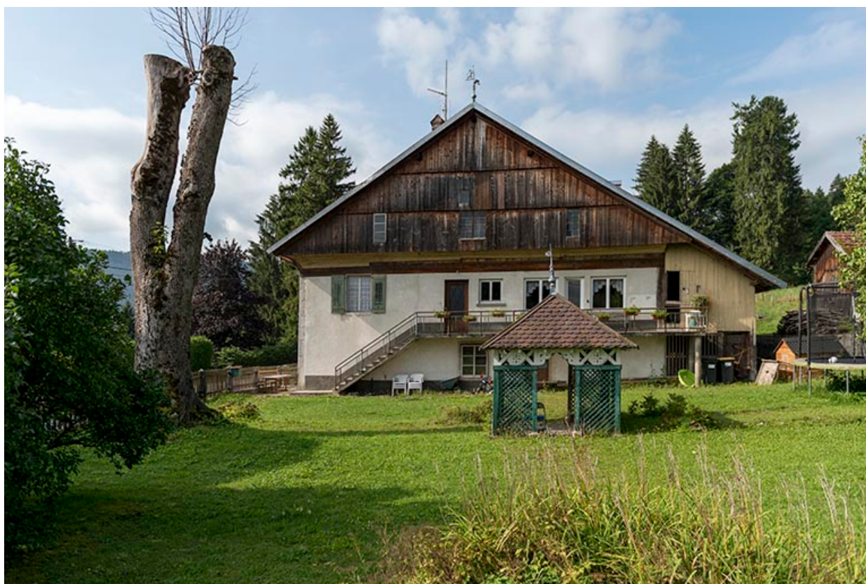
Façade latérale droite.
