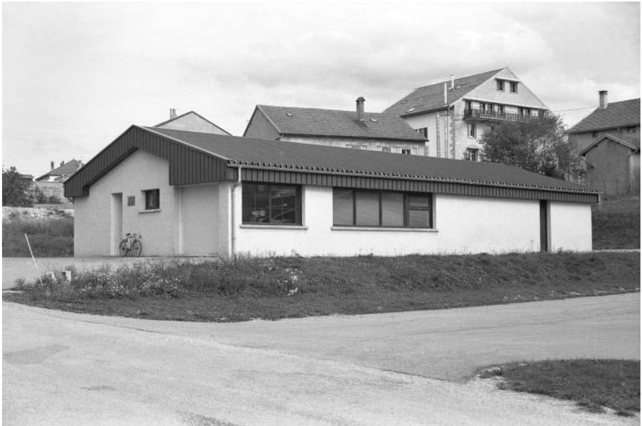
La nouvelle usine (rue Lacuzon).
