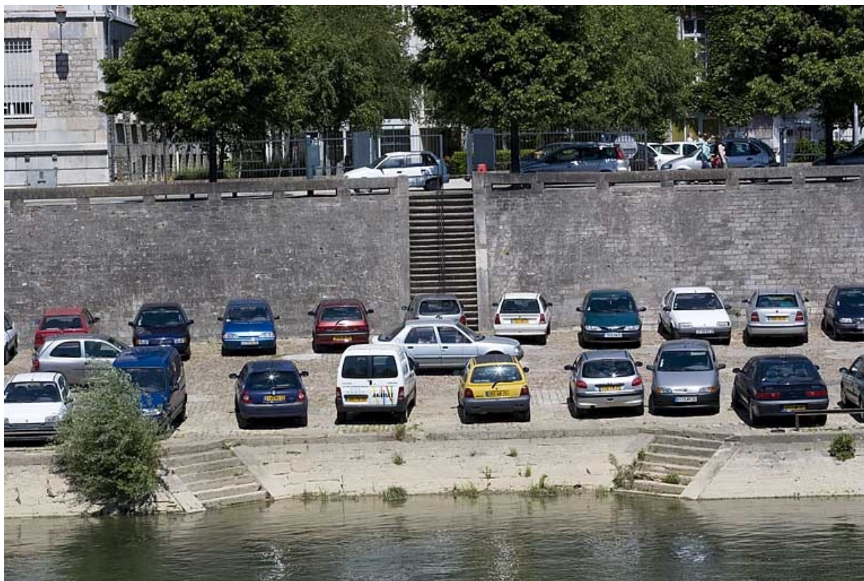
Escaliers d'accès au port et au Doubs.
