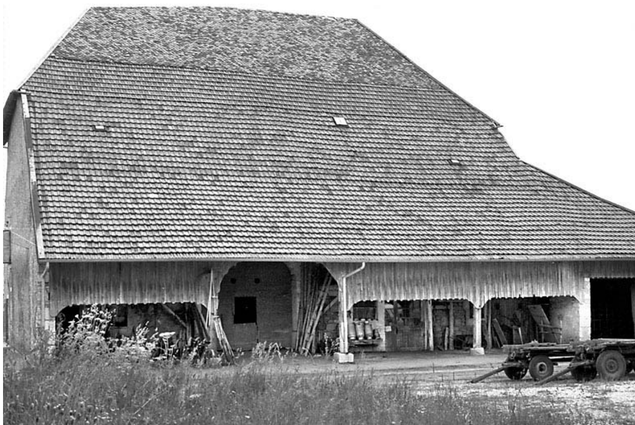
Vue du mur long-pan sur rue.
