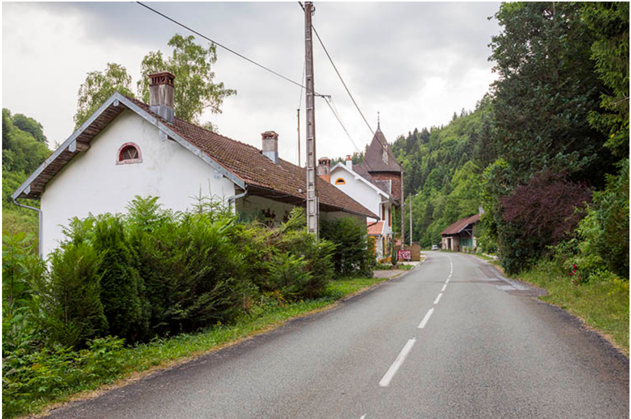
Vue d'ensemble du site, depuis le nord.
