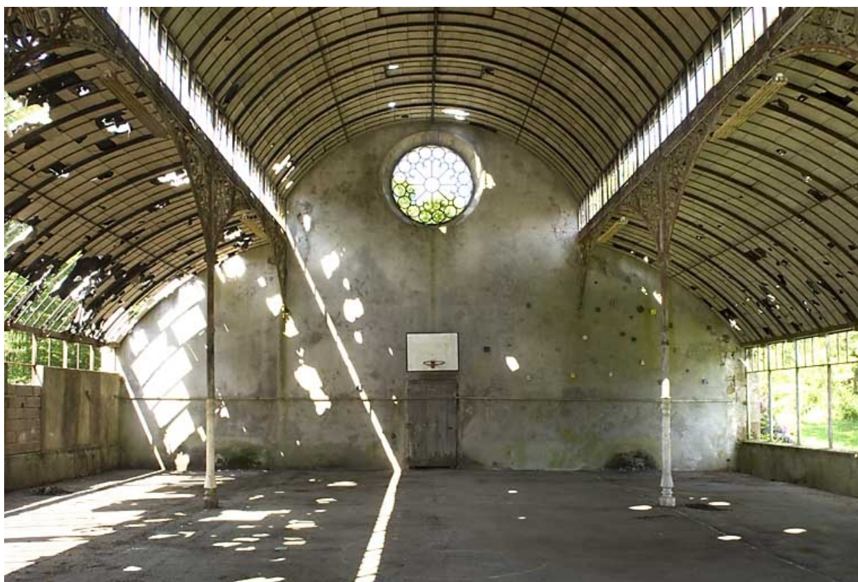
Intérieur de la serre. Vue depuis l'est.
