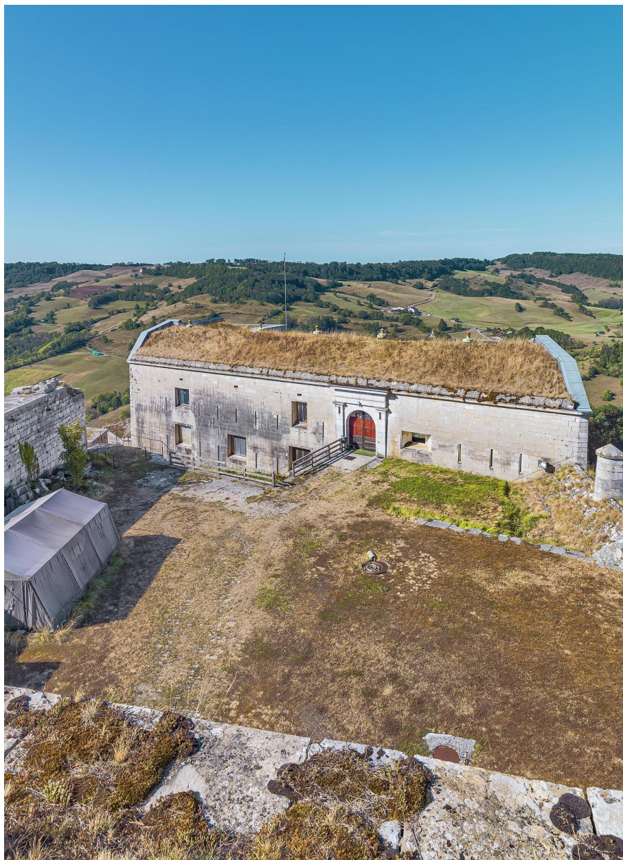
Vue depuis le toit du cavalier.
