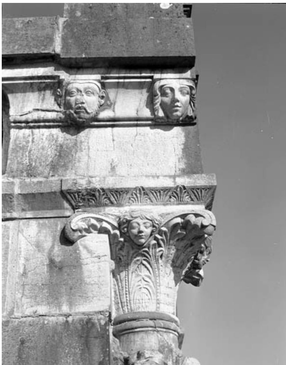
Détail du chapiteau gauche.
