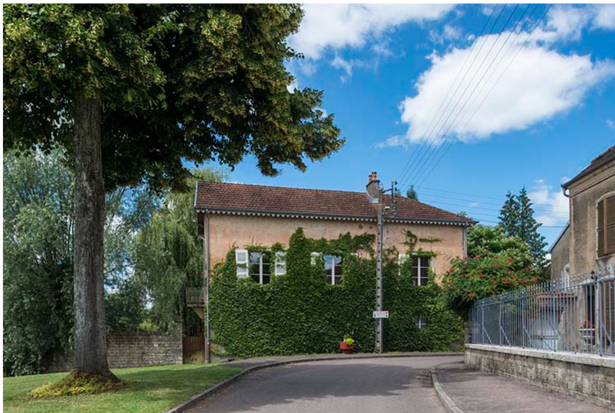
Ancienne tannerie, grande rue du Bourg.
