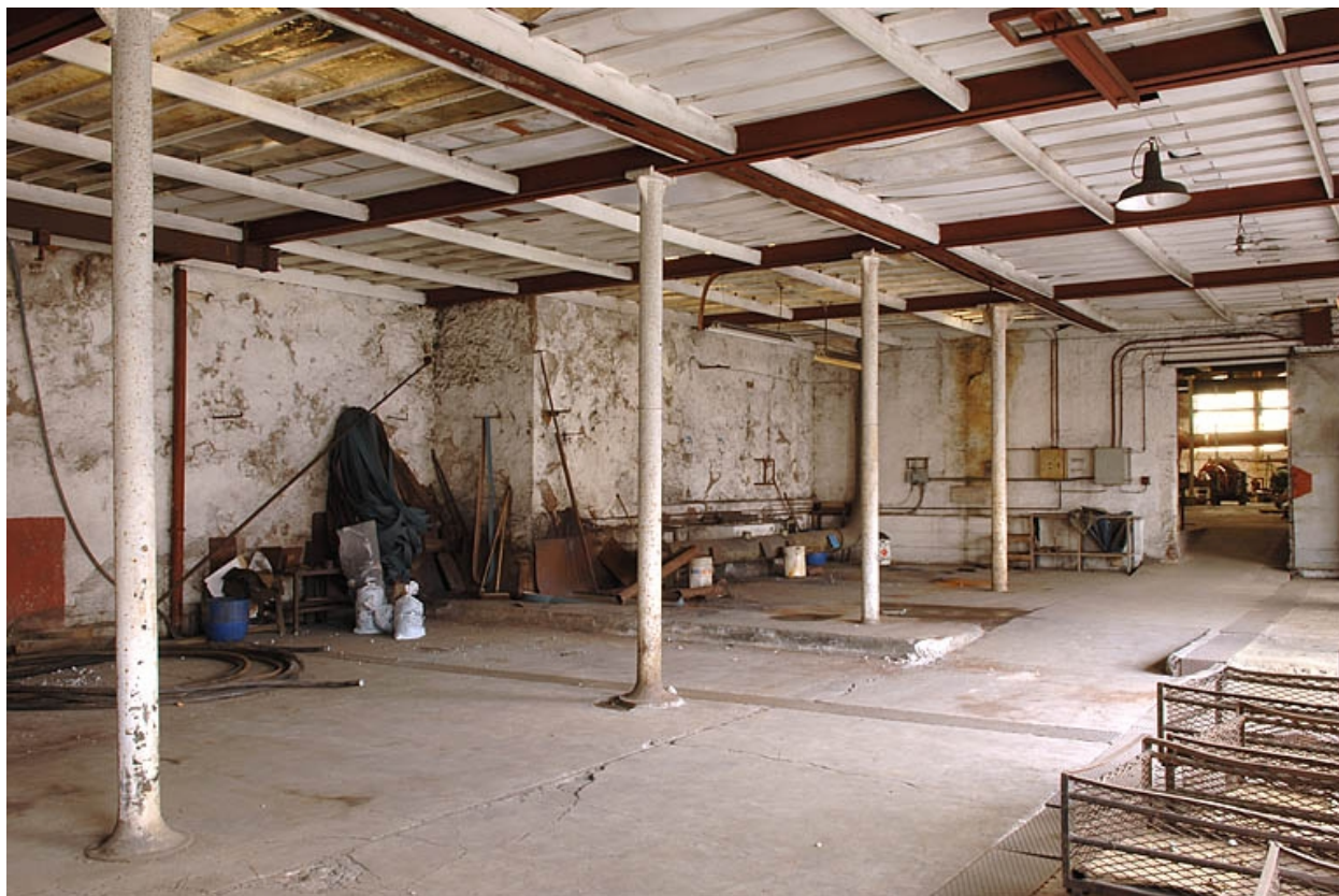
Vue d'ensemble de l'atelier de polissage.
