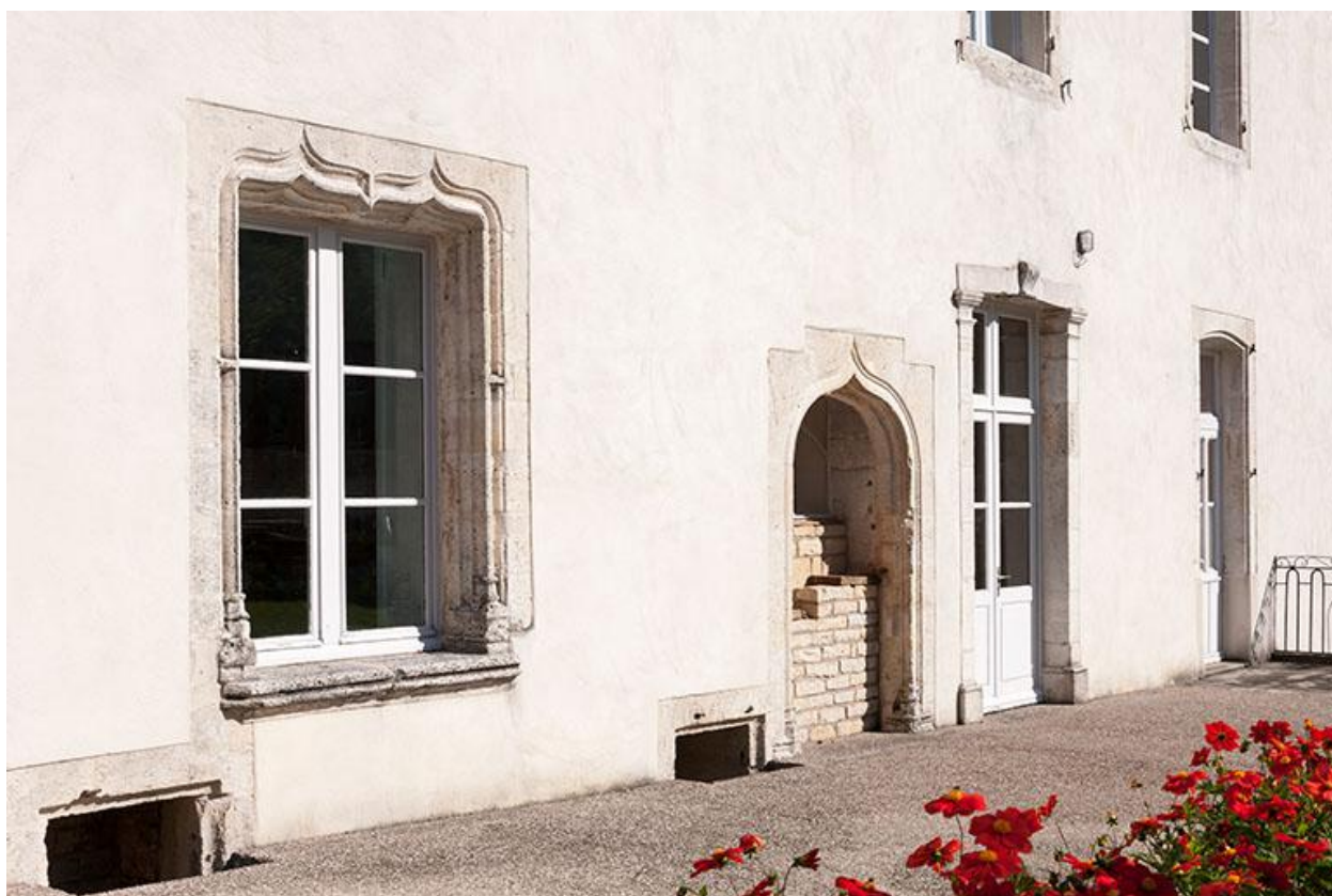
Détail de la façade sud
