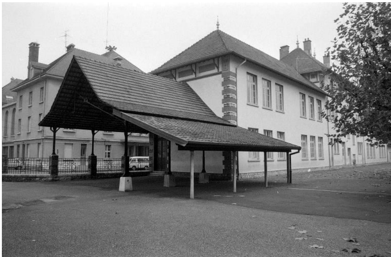
Façade sur cour, de trois quarts gauche.
