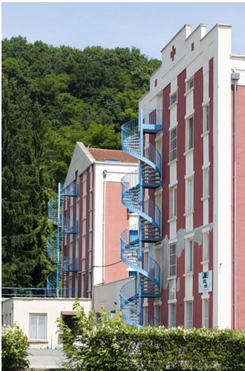
Immeubles de dortoirs. Pignons ouest.
