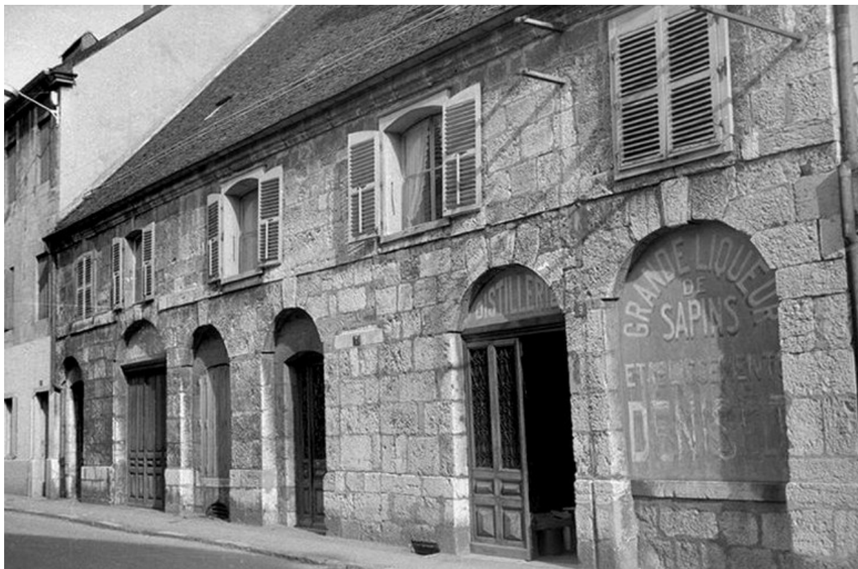
Façade ouest en 1968.
