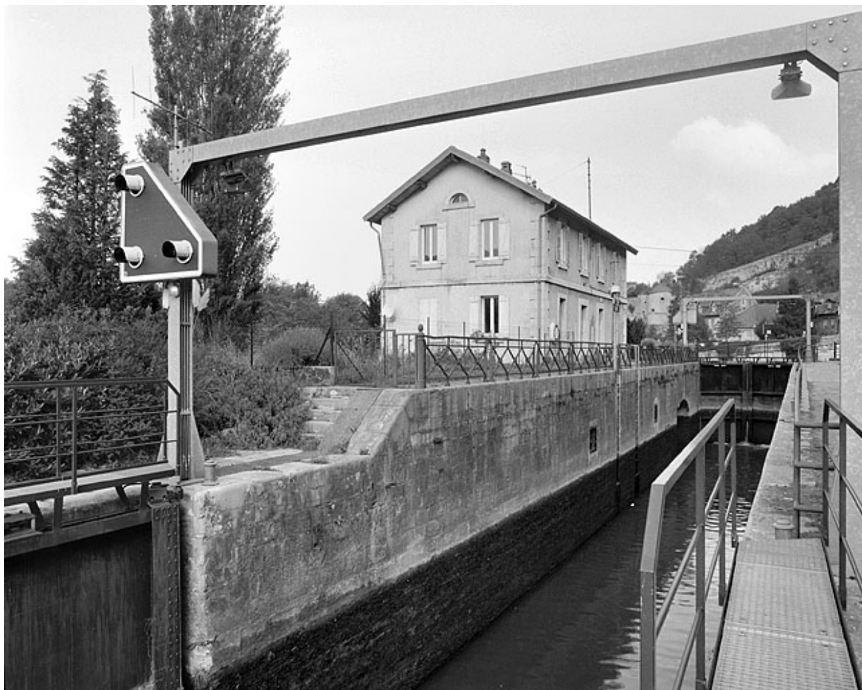
Intérieur du sas, de trois quarts.
