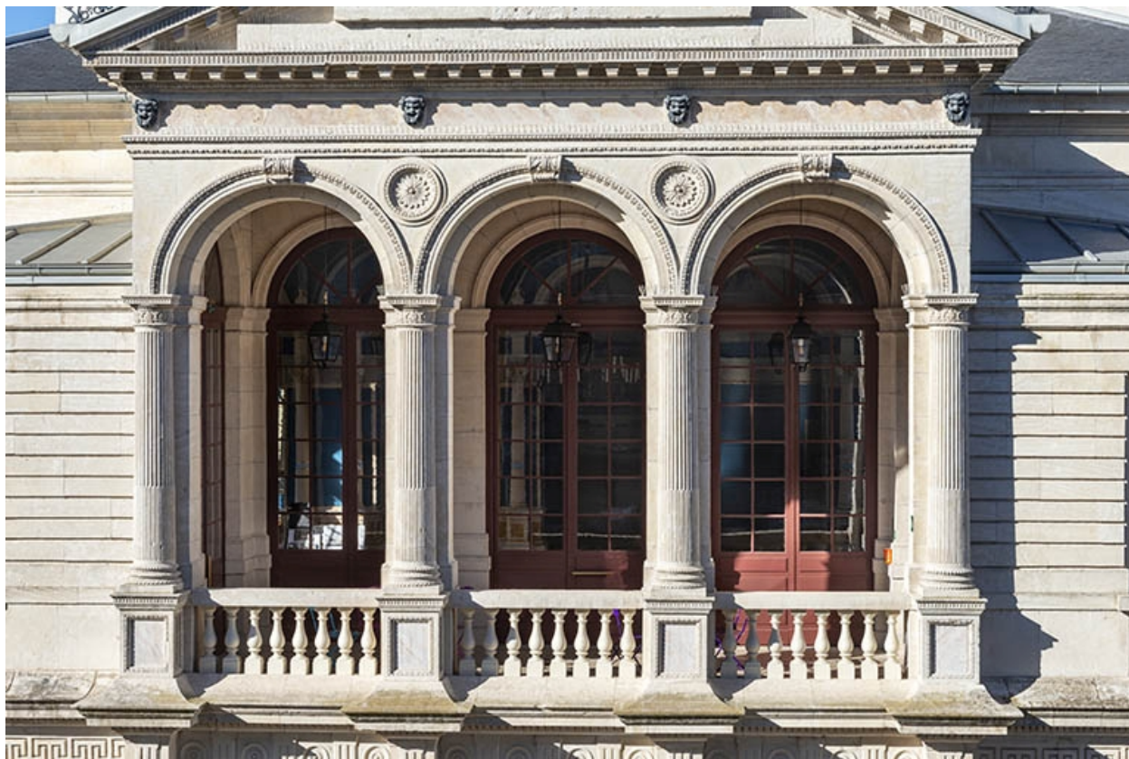
Façade antérieure, étage : baies de la loggia.
