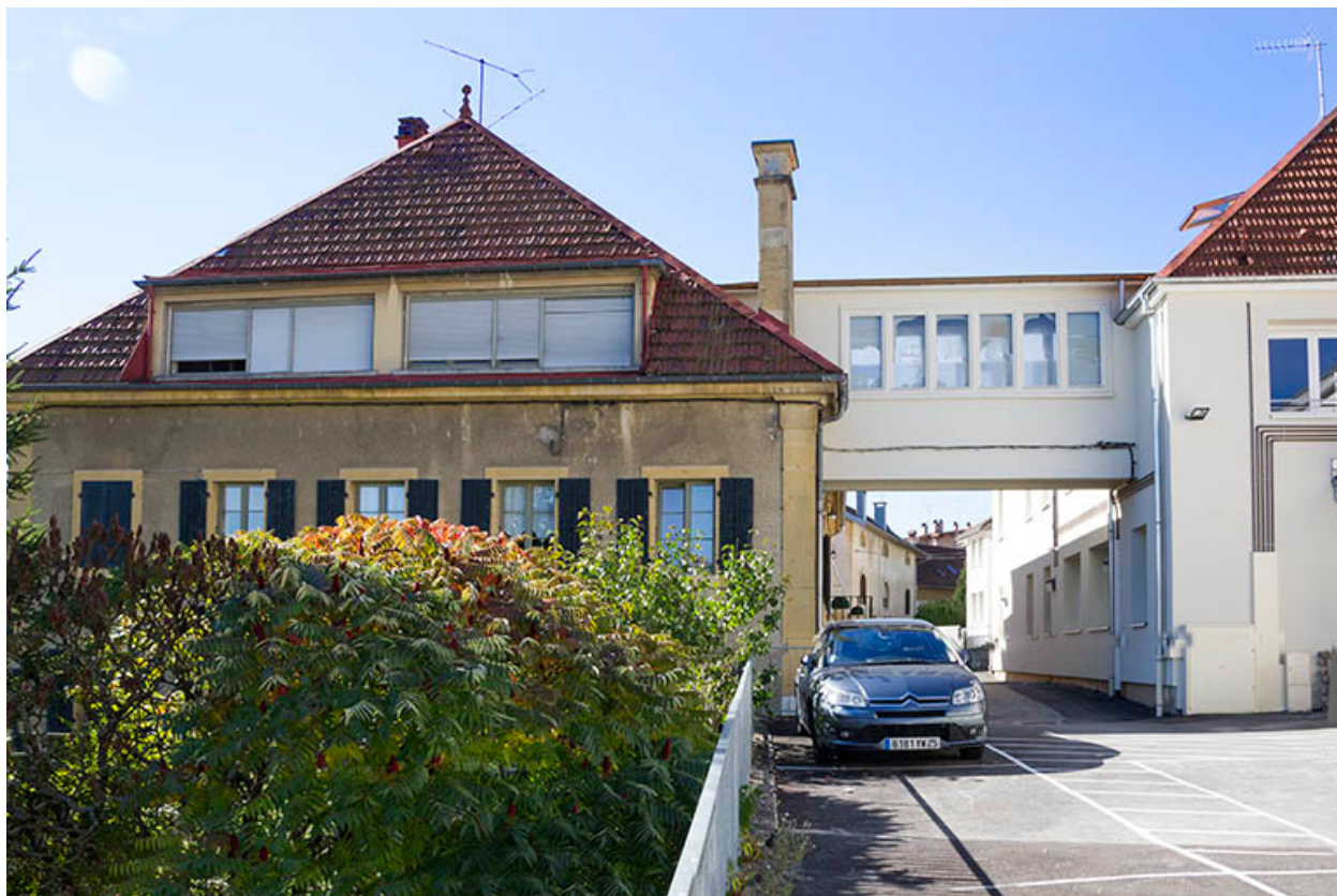
Maison : façade postérieure et passerelle.
