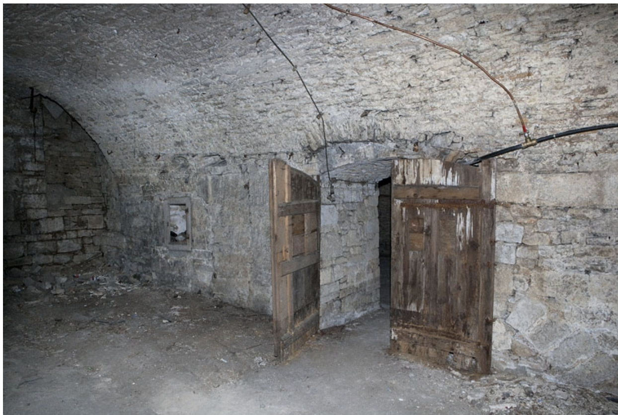
Logis principal, sous-sol : cave C.
