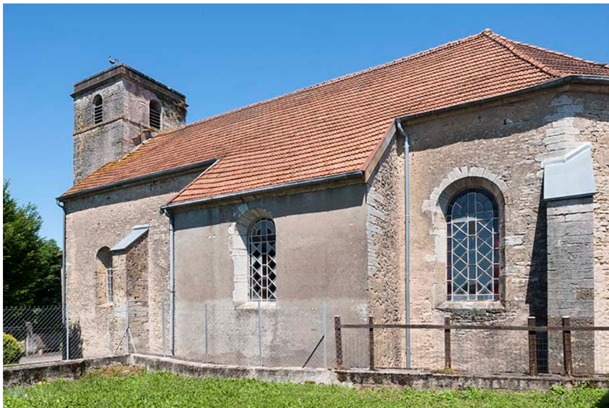
Vue latérale Sud
