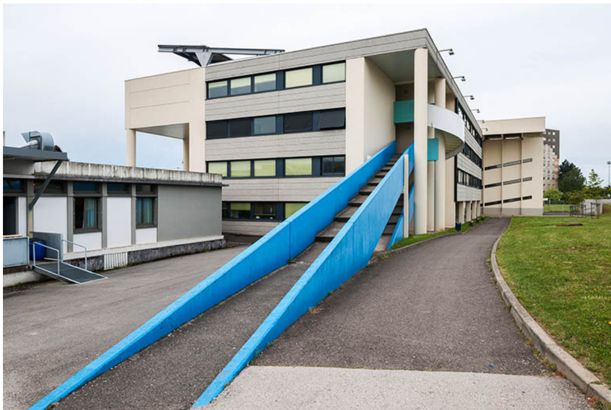
Bâtiment d'externat avec rampe d'accès.
