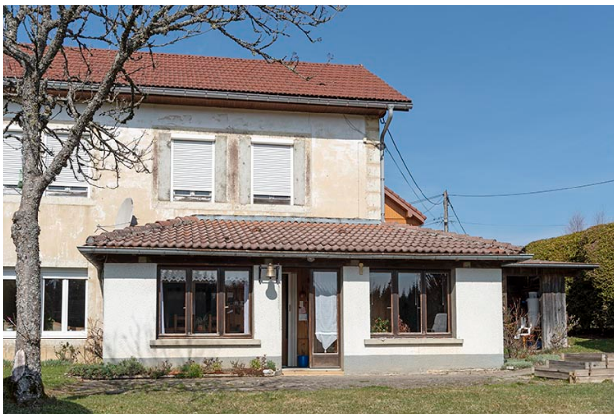
Façade postérieure : extension orientale.
