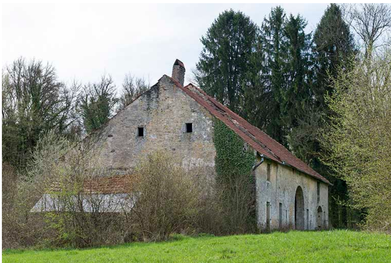
Le mur pignon nord.
