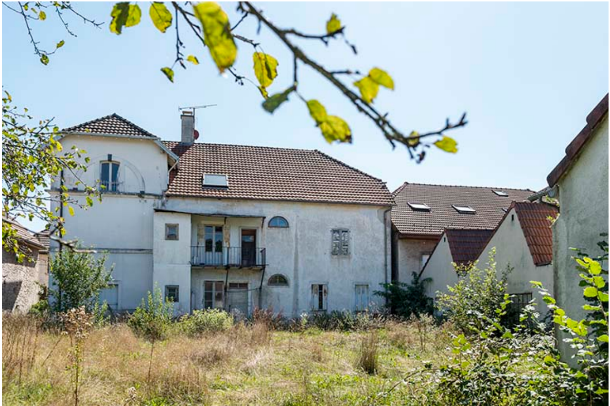
Logement : façade postérieure.
