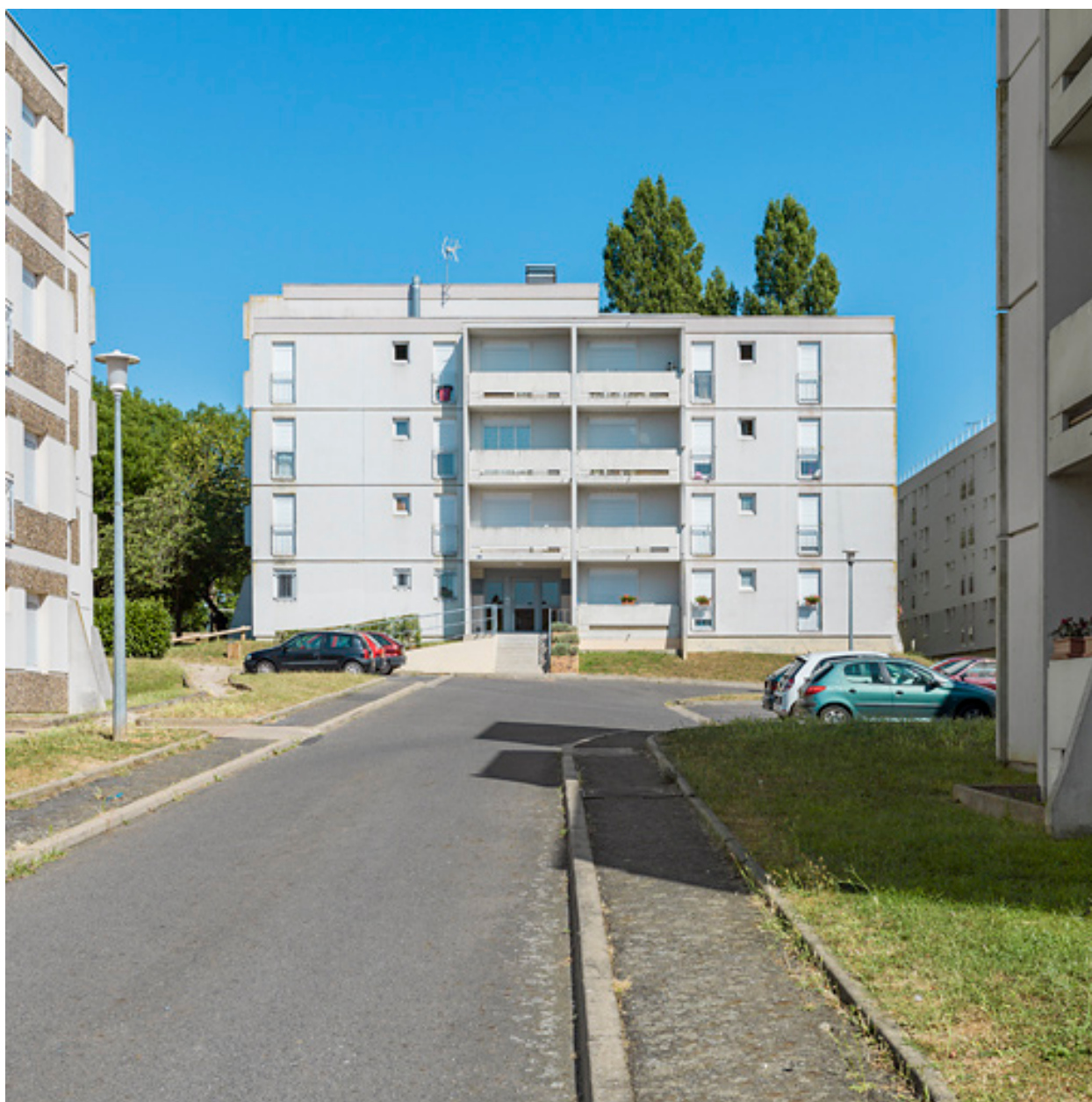
Bâtiment 27, façade antérieure ouest.
