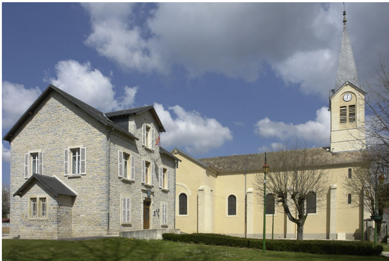
Elévation latérale gauche, vue d'ensemble avec au premier plan, l'ancien presbytère actuellement mairie.
