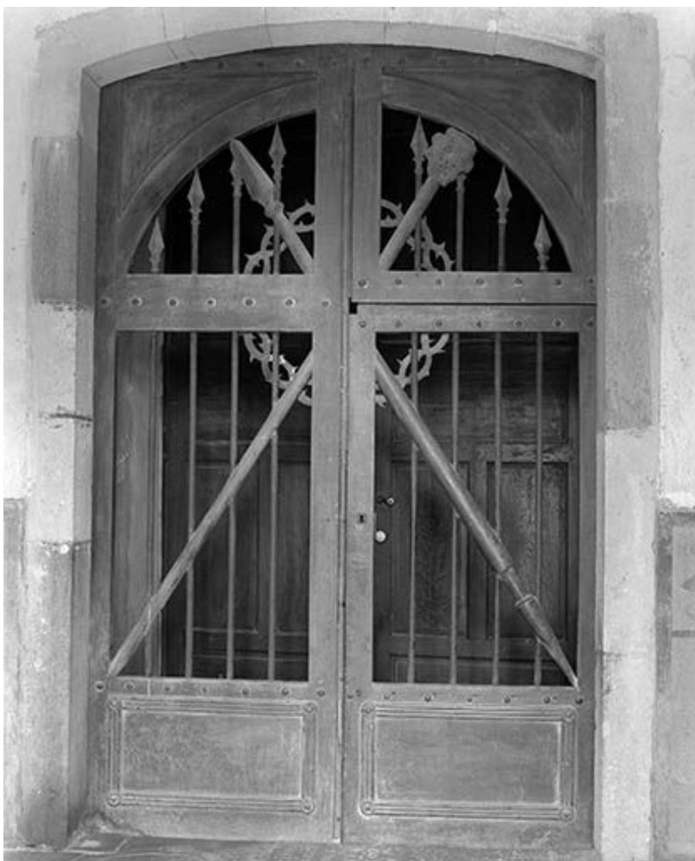
Porte conduisant à la nef.
