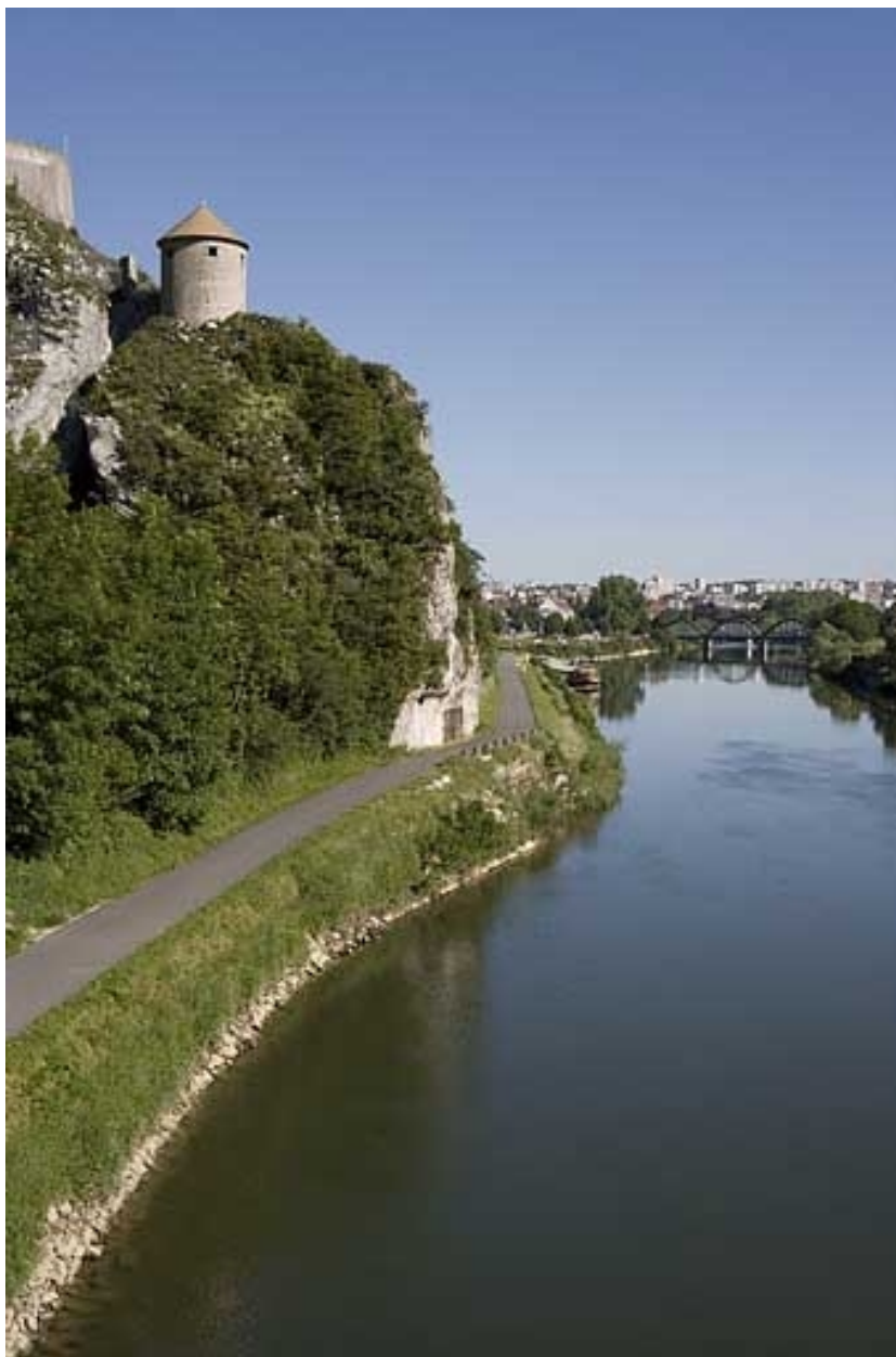
Vue d'ensemble du site depuis l'amont.
