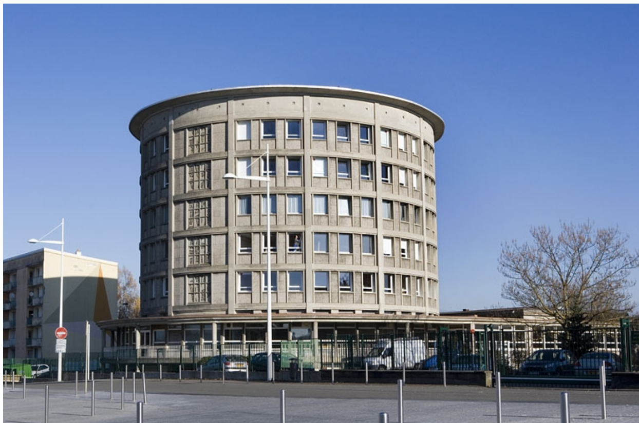
Bâtiment D. Tour internat.
