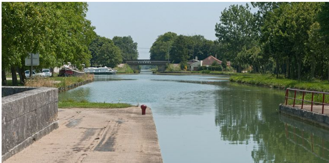
Vue d'ensemble du port.
