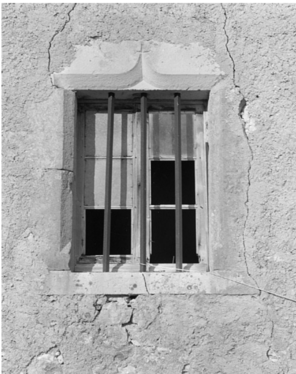
Une fenêtre au linteau en accolade.
