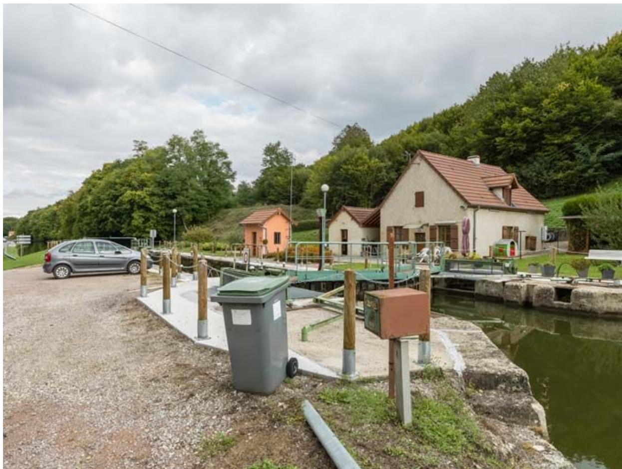
Vue d'ensemble du site d'écluse.
