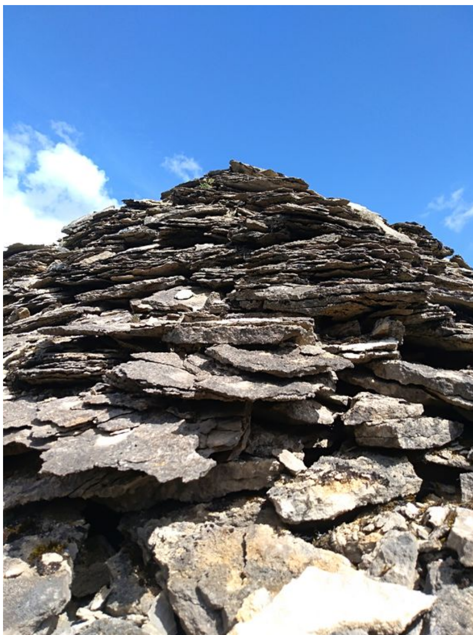
Détail de la toiture en laves, avant restauration.
