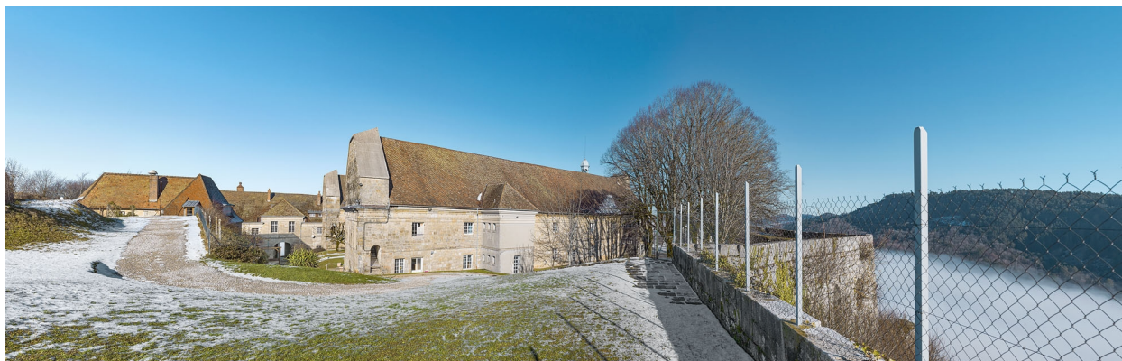
Vue intérieure depuis le sud.
