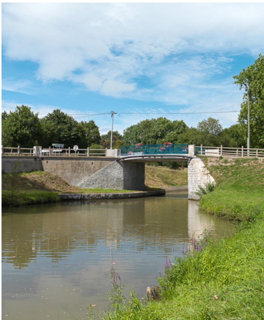
Vue d'ensemble du pont.
