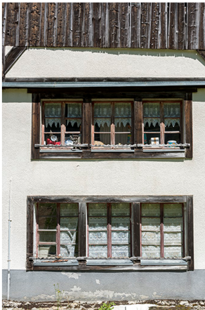
Façade antérieure : fenêtres multiples.
