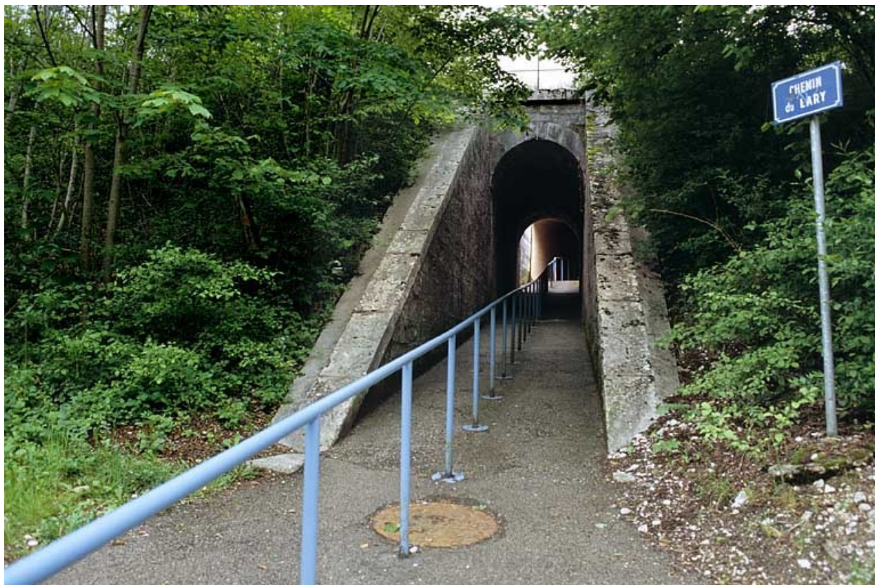
Vue d'ensemble de la tête aval (nord).
