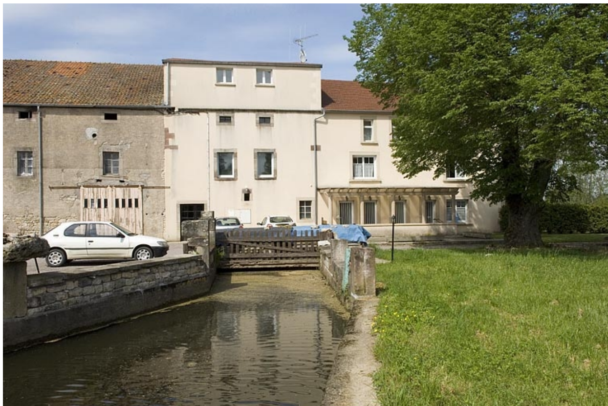
Bief d'amenée et façade antérieure.
