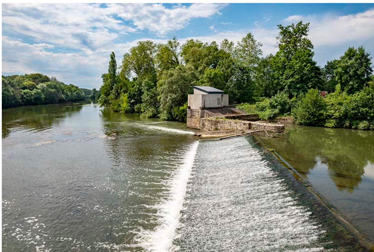
Vue générale sur le déversoir.
