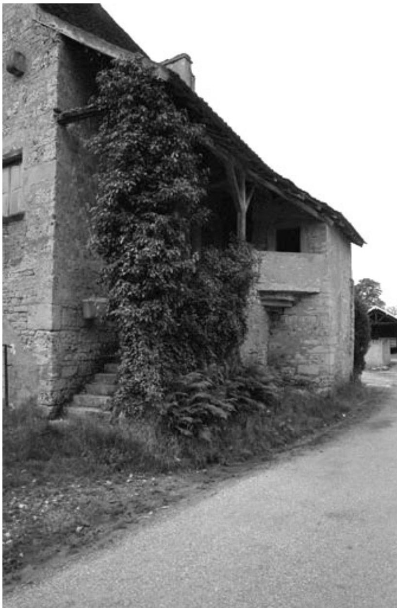
Détail de l'escalier extérieur sur façade antérieure.
