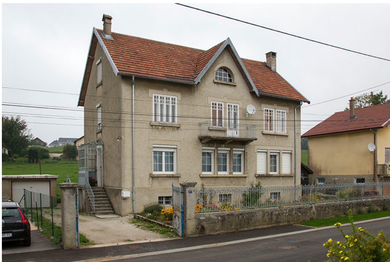
Façades antérieure et latérale gauche.
