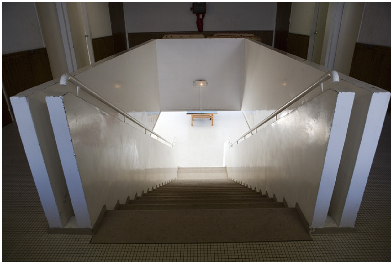
Escalier intérieur : la rampe béton.
